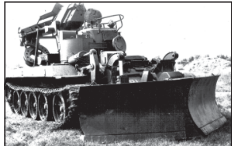
ІМР-2 — інженерна машина розгородження з додатковим освинцюванням екіпажу масою 7 тон. Працювала з великим рівнем радіоактивного опромінювання до 1 тис. ренген на годину.
