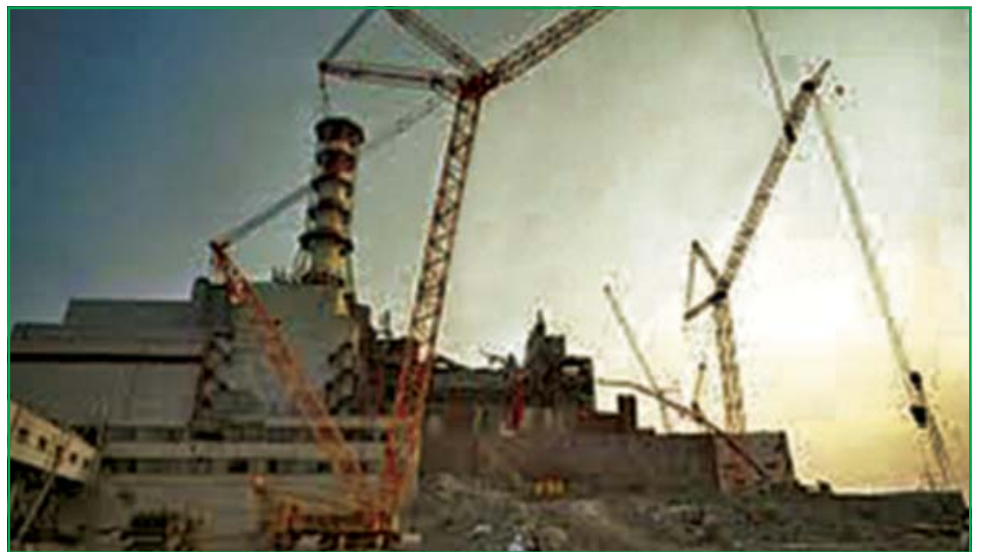
Монтаж 2-х баштових кранів «ДЕМАГ» на 4-му блоці ЧАЕС. 1986 р.
