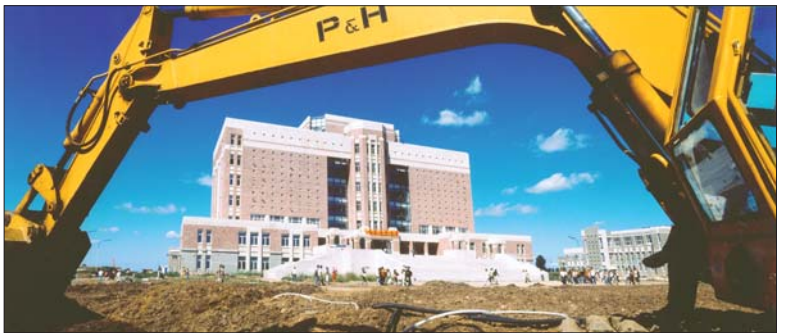
Китай. Будівництво університетської бібліотеки в м. Шеньян
