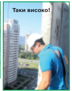
Вигляд будівельного майданчика з монтажного горизонту.
