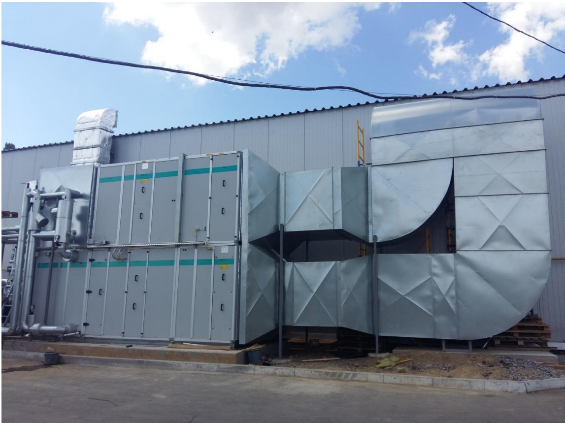
Рис. 4.7 Центральний кондиціонер з механічним спонуканням повітря для задоволення потреб з забезпечення необхідного мікроклімату (температури та вологості повітря) в приміщенні зберігання насіння гарбузу, з конденсаційним осушенням повітря.
