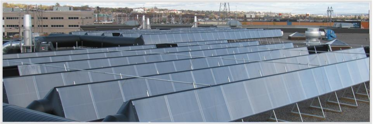
Рис. 1.6 . Геліополе повітряної ГСТ на основі колекторів Luba GL в Монреалі.
