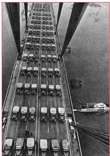
У процесі випробувань судна продовжували ходити під навантаженням мостом
