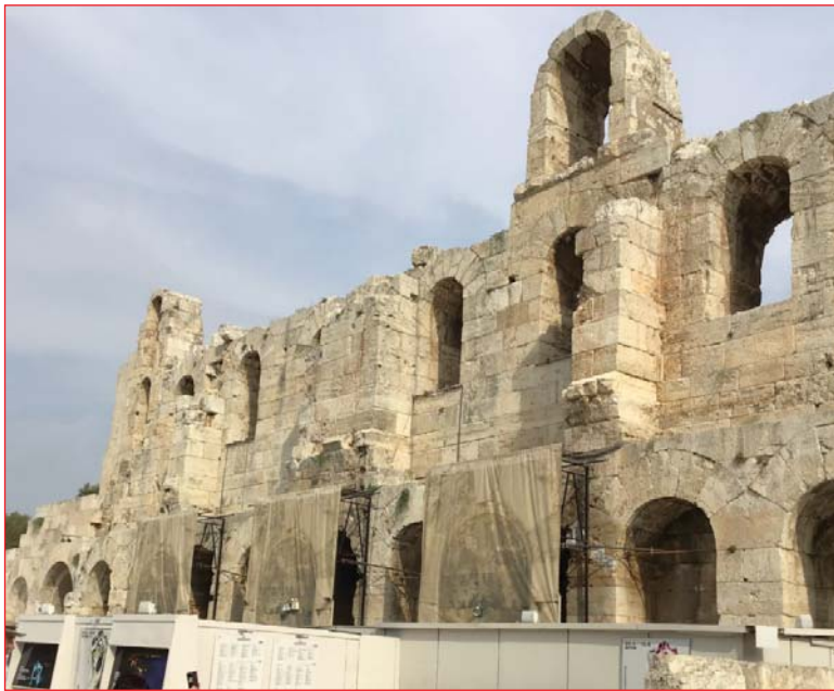
Реставрационные работы на Акрополе
