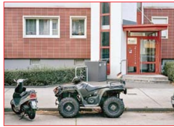
Посмотрите, как отделан первый этаж этих панелек и как модернизирован вход в подъезд
