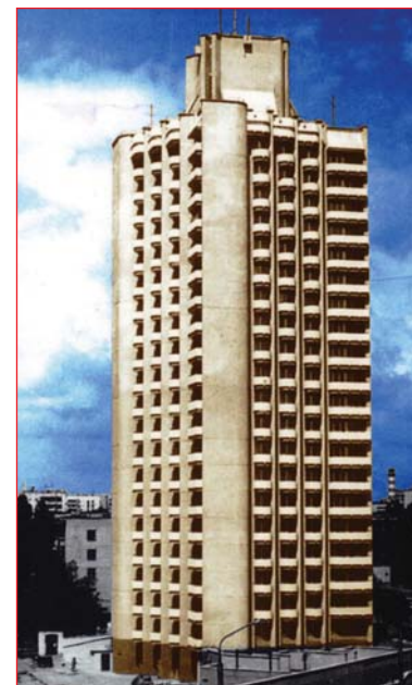
Багатоповерховий будинок збірно-монолітного типу з шпалолужного бетону в Липецьку, побудований в 1987 р.
