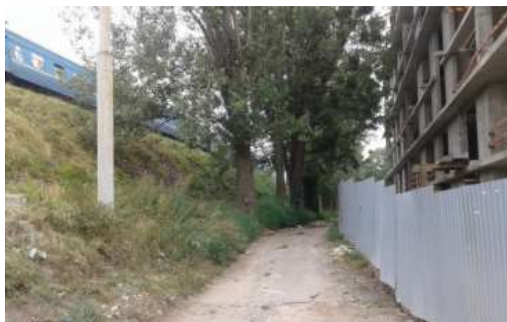
Рис.1.8. Законсервоване будівництво в охоронній зоні залізниці (м. Львів)
