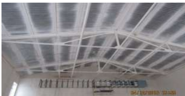
Рис.2.18. Візуальне обстеження будівельних конструкцій
