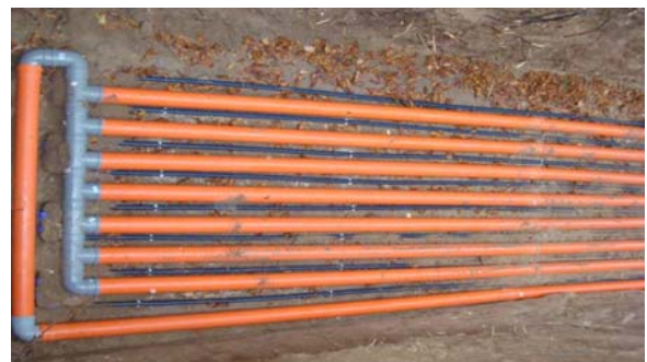
Рис. 11. Принципова схема теплової завіси (а) та теплообмінник типу «ґрунт – повітря» (б)
