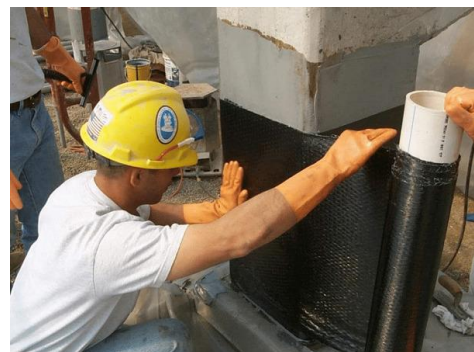
Рис. 2. Фрагмент виконання робіт з підсилення колон вуглеволокном
