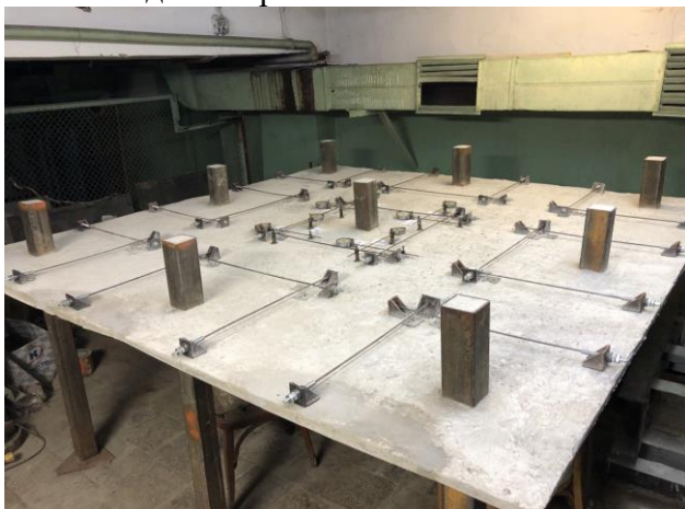
Рис.1 - Загальний вигляд залізобетонної плити підсиленої зовнішньою напруженою арматурою
