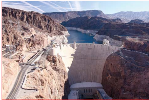
Плотина Гувера на реке Колорадо. 1933 г.
