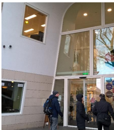
Огляд реконструйованого житлового району Амстердаму
