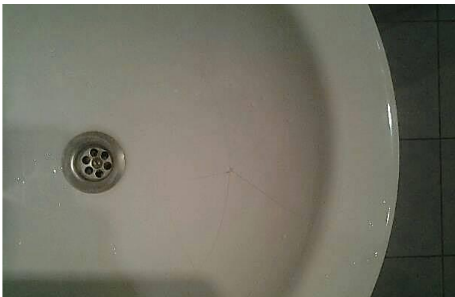
Рис.2.2. Розтріскування чаші – механічне пошкодження
