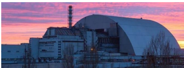
Рис. 1.6.1 Чорнобильська атомна електростанція [№11]
