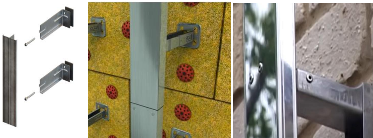
Рисунок 2.10 – Монтаж направляючих
