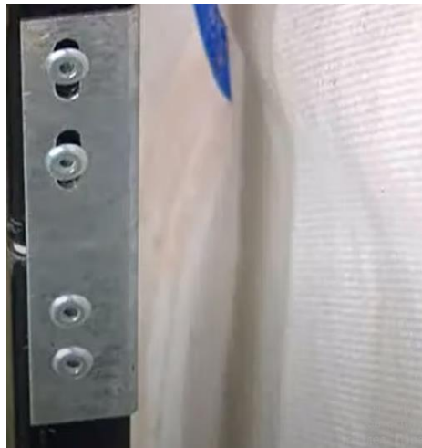
Рисунок 2.11 – Монтаж направляючих
