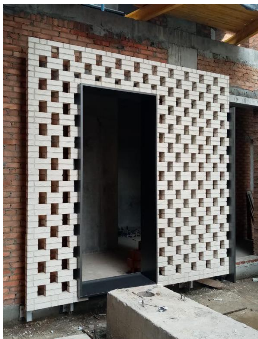
Рисунок 4.4 – Конструктивне рішення зовнішніх стін фрагменту фасаду
