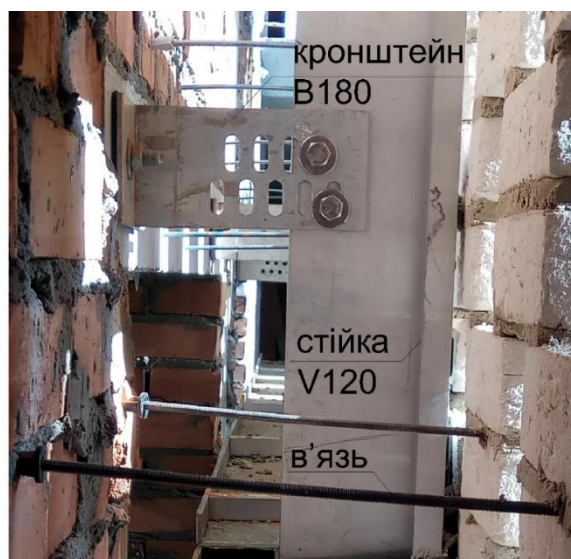
Рисунок 4.7 – Конструктивне рішення зовнішніх стін фрагменту фасаду
